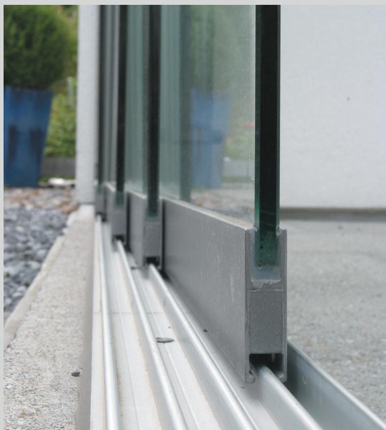
Ganzglas-Schiebewand aus nicht getrennten Aluminiumprofilen für leichte, grossflächige Anwendungen.
